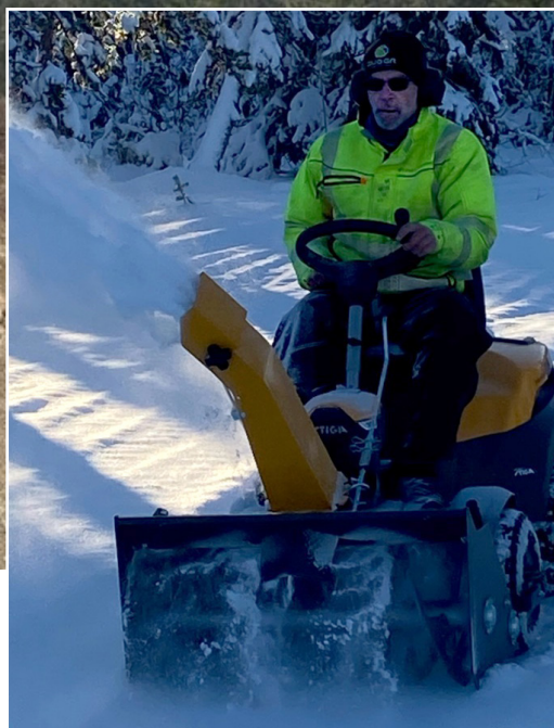
Etablering av tele i vinterbilvegen fra Monaplassen ved bruk av lett utstyr før telen er tykk nok til å bære traktor. Svein Bjørnbakken i Vang Almanning freser vekk snøen.
