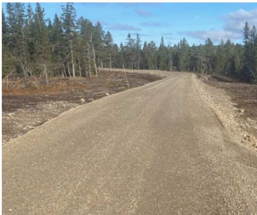
Breivegen ferdigstilt i august og klar til bruk.
