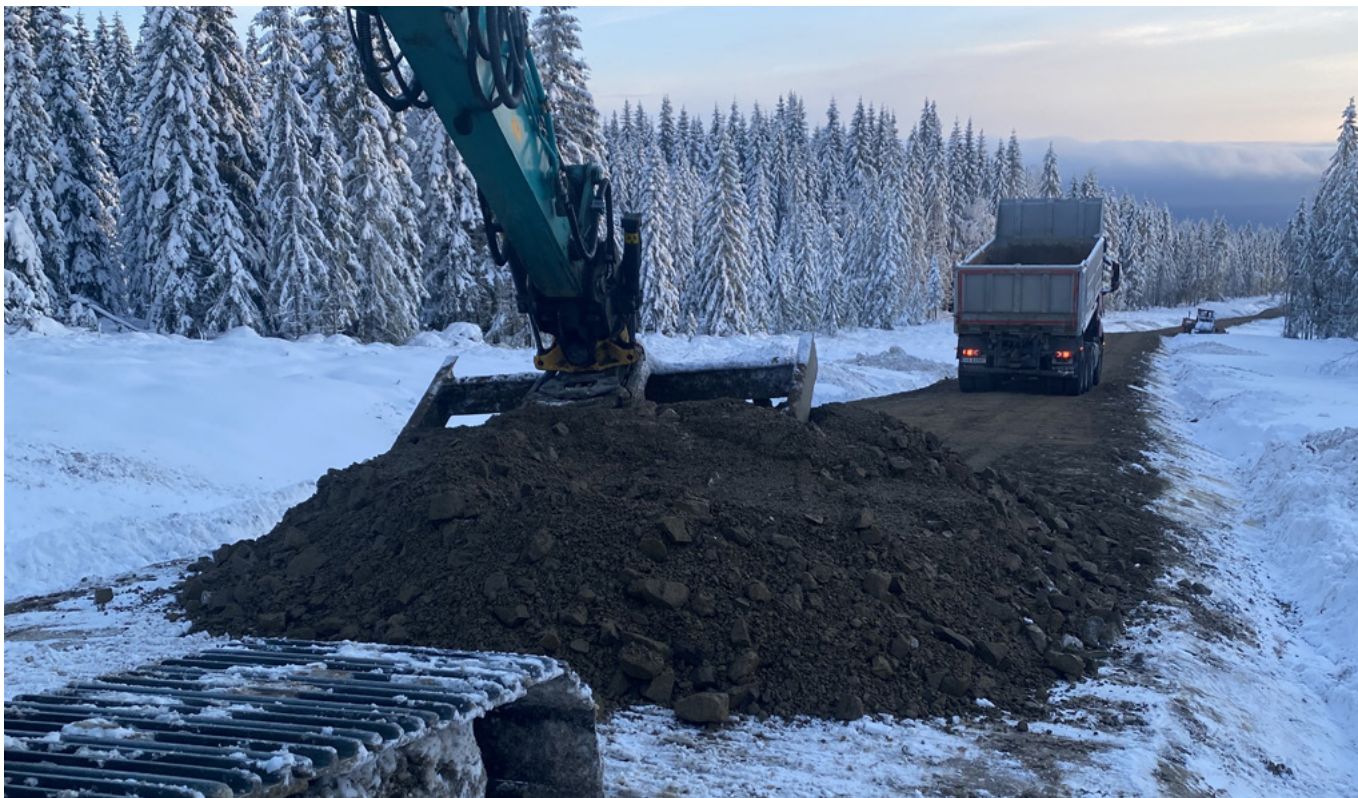
Legging av bærelag på Breivegen.
