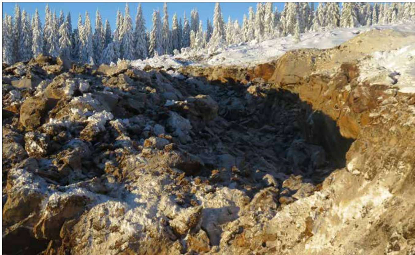
Resultat av sprenging.
