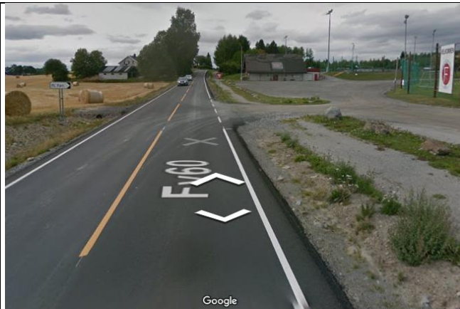
Bilde 14: Fartvegen (fv. 227) sett mot Fartbana. Enkelt gang- og sykkelveg er etablert langs vegen. (google street view)
