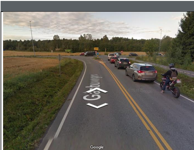
Bilde 1: Gåsbuvegen fv. 1796 sett mot kryss Sælidvegen fv. 224. (google street view)
