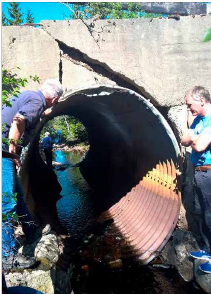
Styret konstaterer at røret der Stensæterbekken krysser Fjellveien må skiftes.
